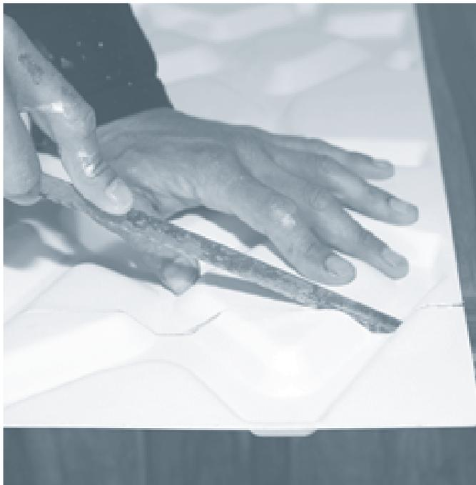
Cortar con precaución en línea recta siguiendo la línea marcada con el lápiz.
