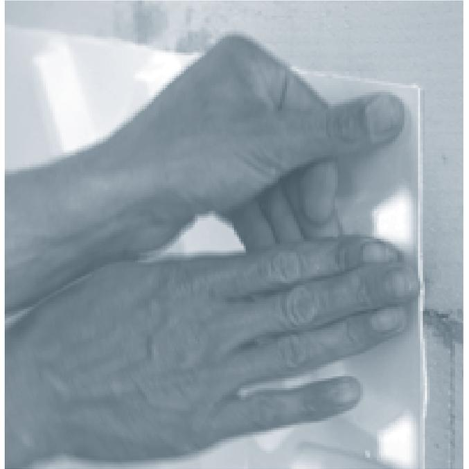
Aplicar presión a todas las esquinas del panel durante su instalación.
