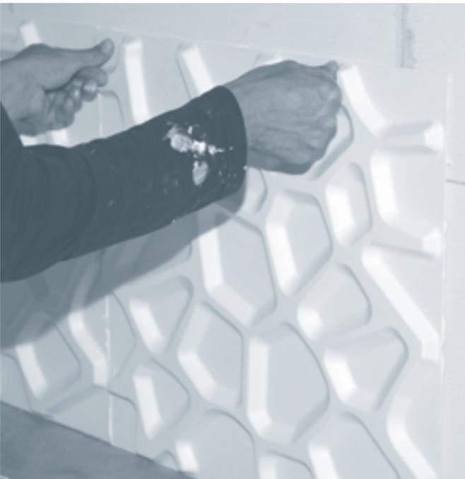
Alinear con los demás paneles ya instalados y confirmar usando el nivel durante la instalación .
