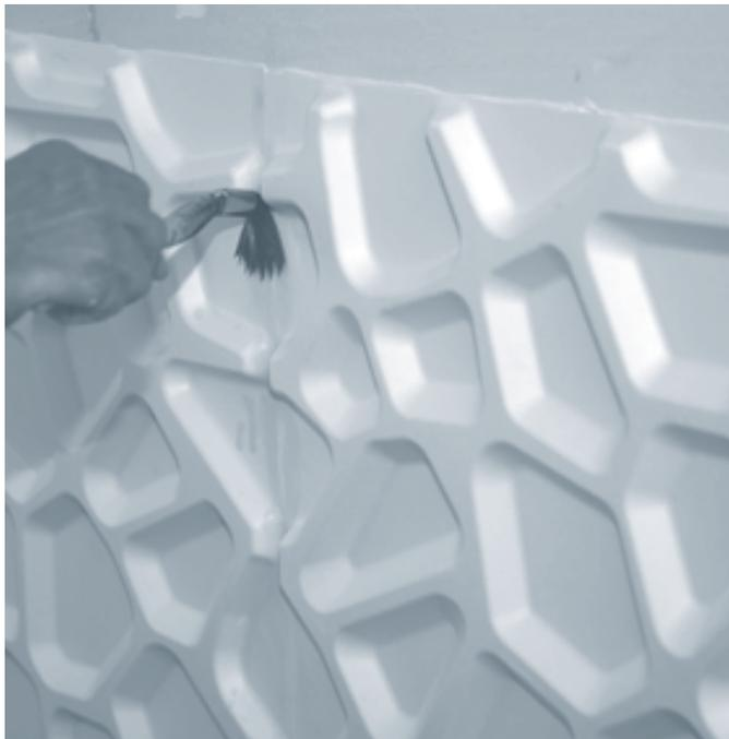
Limpiar uniones con una brocha para cualquier filtración a través del adhesivo.
