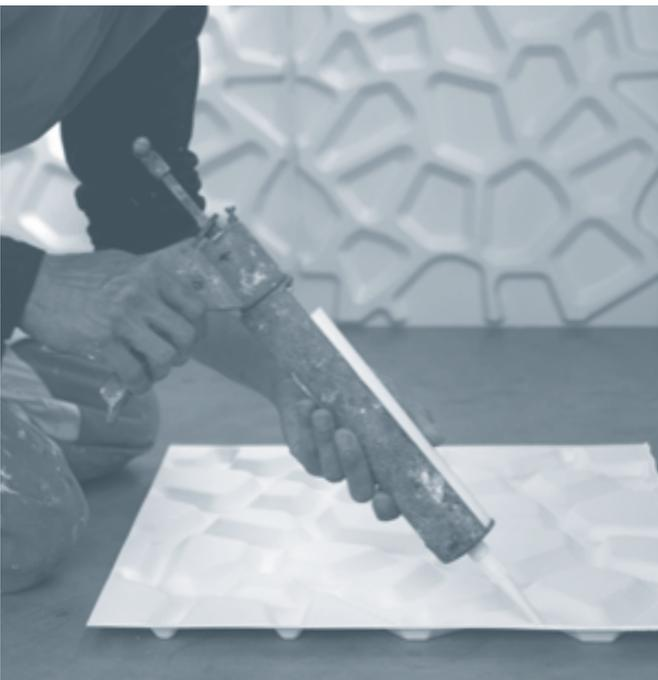
Aplicar el adhesivo a todos los lados de la parte posterior del panel.
