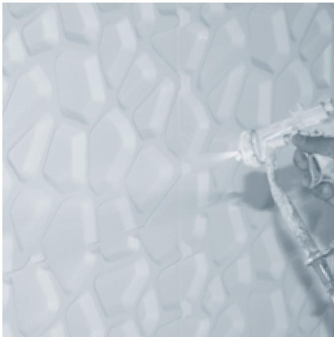
Aplicar Primer a los paneles instalados (Spray, Brocha ó Rodillo).
