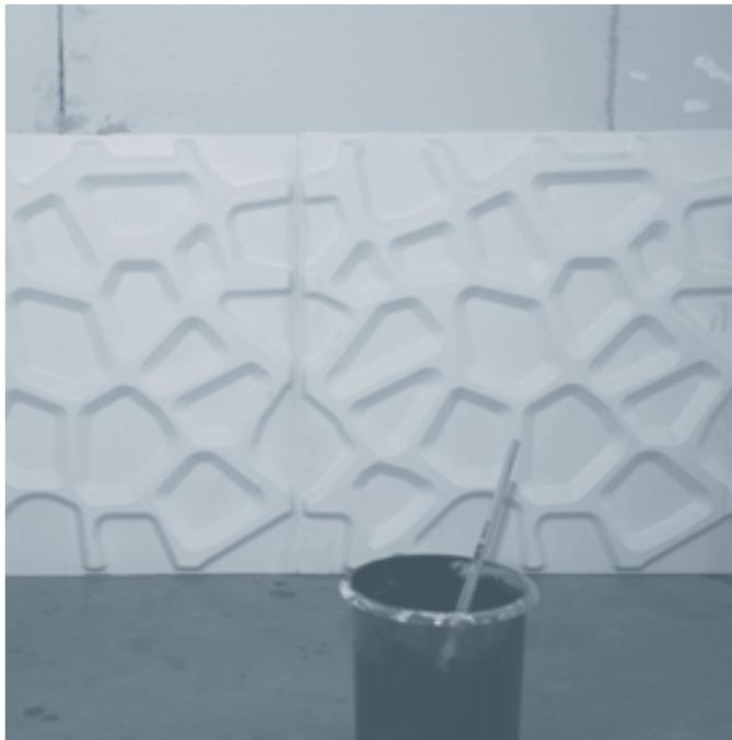
Prepare la limpieza de las uniones para cualquier filtración a través del Adhesivo.
